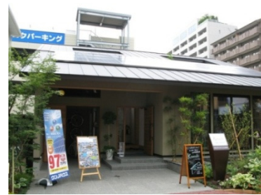
ミニスマートグリッドを構築した住宅 (株)ウンノハウス)
