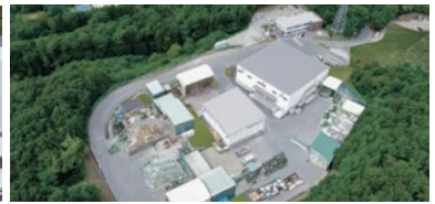
建設混合廃棄物の複合処理施設、ケイワ・リサイクルセンター福島
